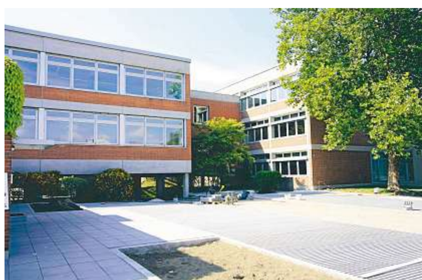
Das Albertus-Magnus-Gymnasium muss bis 2014 warten. Erst dann soll die Generalsanierung starten.
